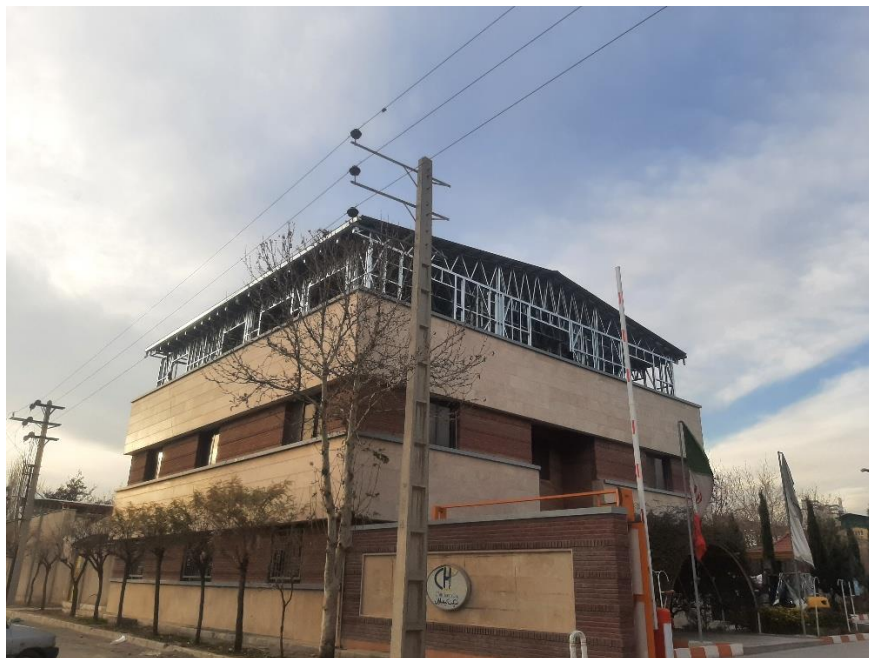
شکل ۲- یک نمونه سازه اضافه بنا به روش ال اس اف در ایران
